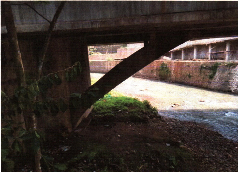
Gambar 4. Abutment Jembatan Cileueur
