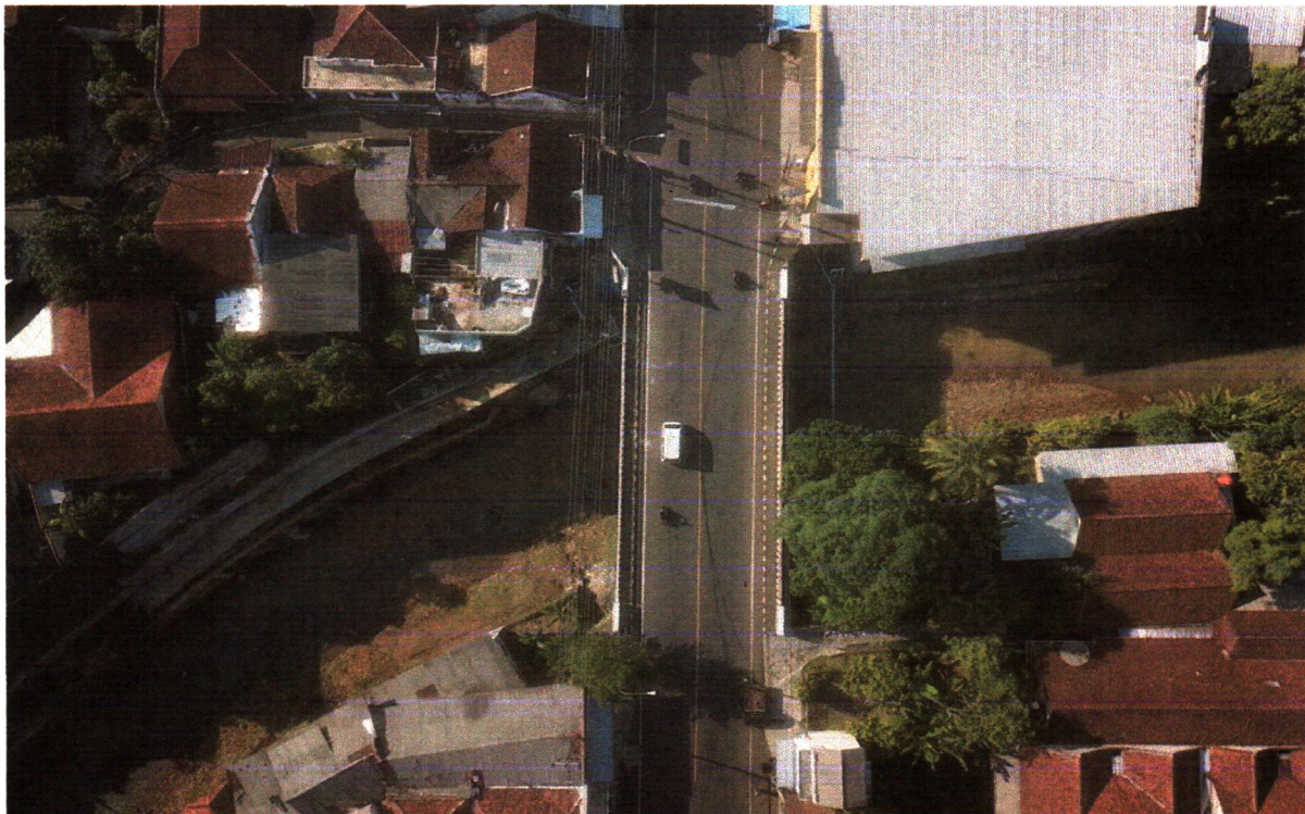
Gambar 6. Foto Udara Lokasi Pemasangan Pipa Air Minum SPAM Ciamis Metode HDD
